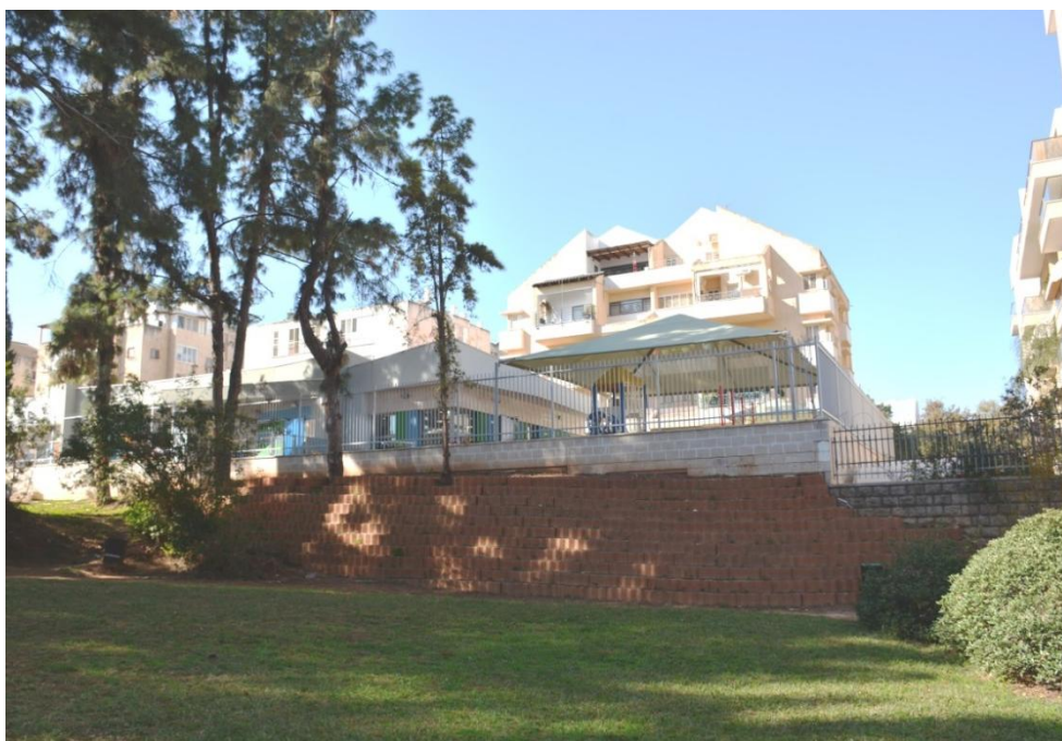
קירות התמך בגבול הגן הדרום מערבי. הקירות הוקמו עם הקמת גני-הילדים ובנויים מחומרים שונים בהם מקטעי אבן טבעית ומקטעי בלוקים טרומיים
