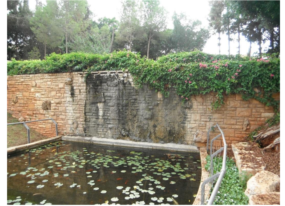
קיר גלישת המים- קיר אבן התואם את התכנון המקורי, לא נראה שבוצעו החלפת אבנים או שיקום של הקיר לאורך השנים.
