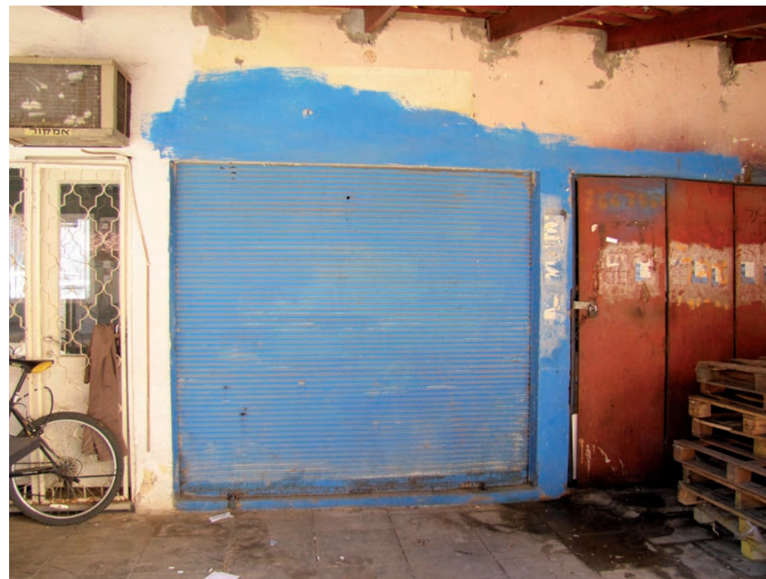
תמונה 19 - תריסי גלילה (מקוריים ככל הנראה) בפתח החנויות הפונות לחצר הפנימית
