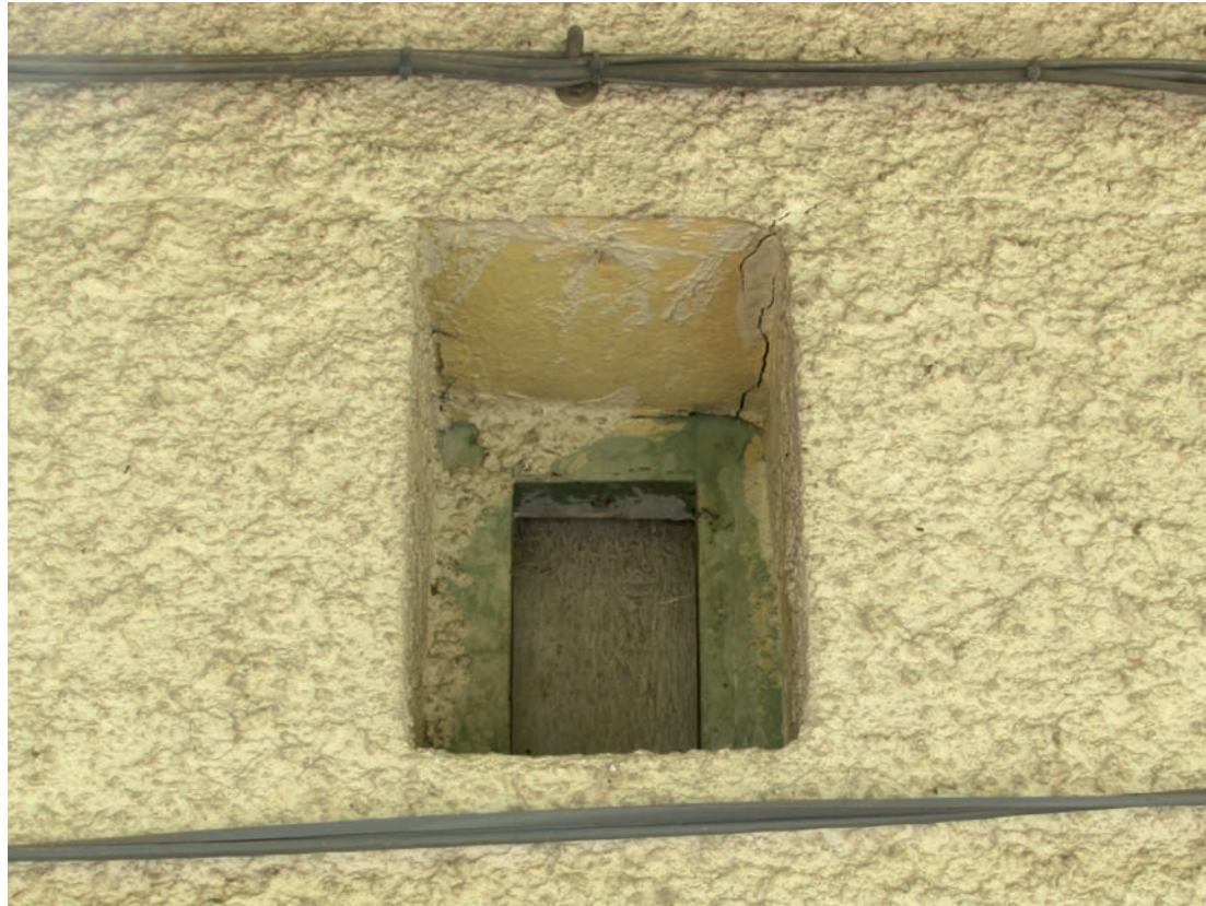
תמונה 22 - חלון אוורור מעץ (מקורי ככל הנראה), במידות 20x30 ס"מ (חזית צפונית)
