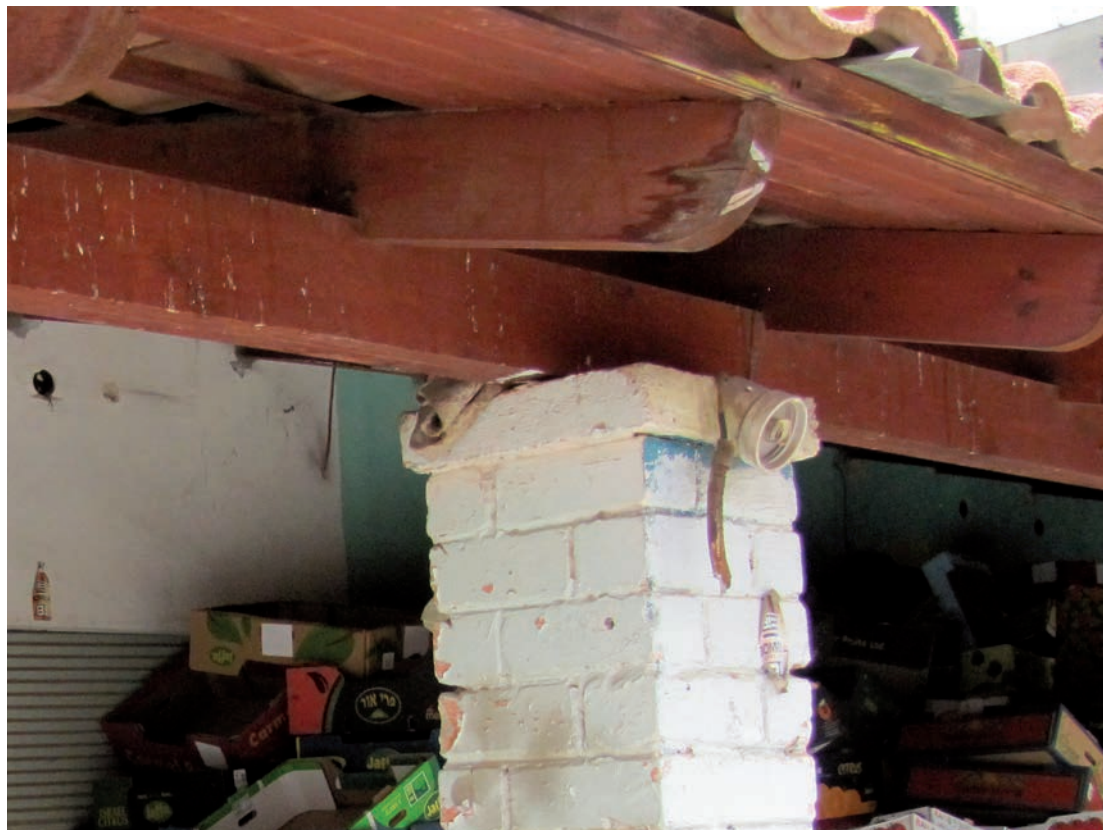
תמונה 24 - קונסטרוקציה עץ של גג הרעפים, מונחת על עמוד סיליקט (חצר פנימית)
