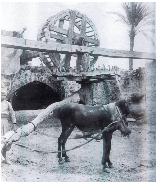
באר אנטיליה- שאיבת מים בעזרת גלגלי שניים עשויים עץ ומופעל על ידי בהמה. הטכנולוגיה רווחה בבארות במישור החוף בא" עד המאה העשרים והכנסת המנוע המוטורי. מקור: מנשה דודזון, "משק ההדרים היהודי בא"
