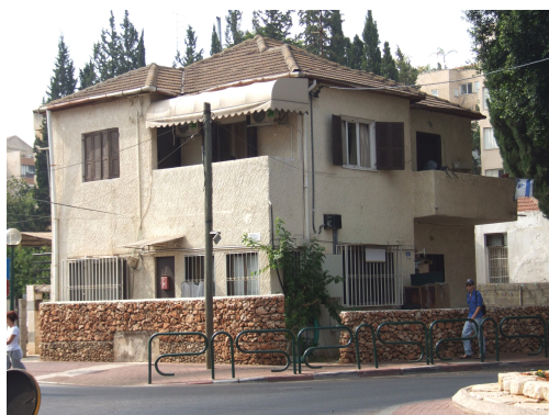
בית אשר פירס, רחוב רוטשילד 42. שנת בניה 1935. דוגמא לסגנון בנייה "מסורתי" במושבה. סגנון הבנייה צנוע ומתאפיין בגג רעפים בעל ארבעה שיפועים ומרוב אבן גלז, פרטי נגרות בחלונות וקירות מטייחים.
