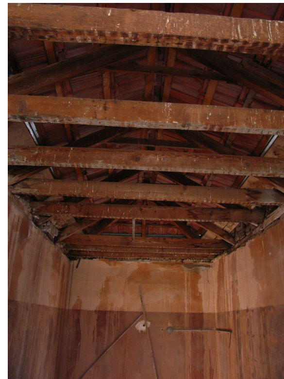
1. גג הרעפים. על הקונסטרוקציה נראים סימני תקרת הרביץ.
